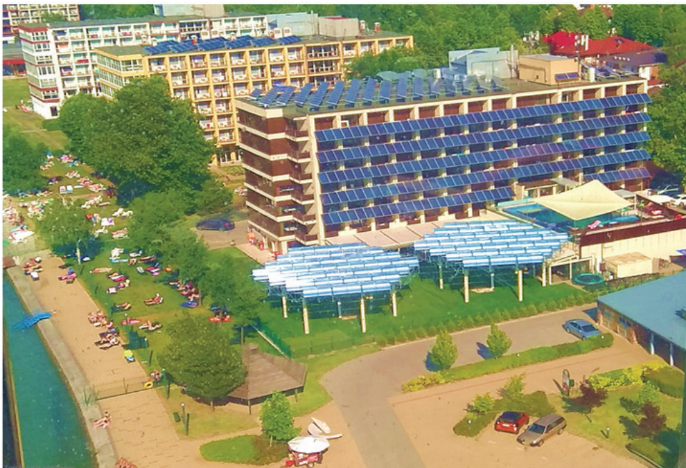
5. ábra: A hotel épületére integrált napelemek és a földre telepített CSP rendszer; Forrás: saját gyűjtés
