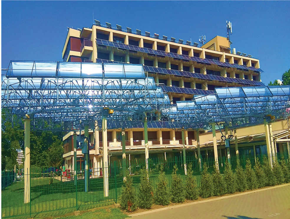
6. ábra: A Balaton Hotel Siófok földre telepített CSP rendszere, Forrás: saját gyűjtés
